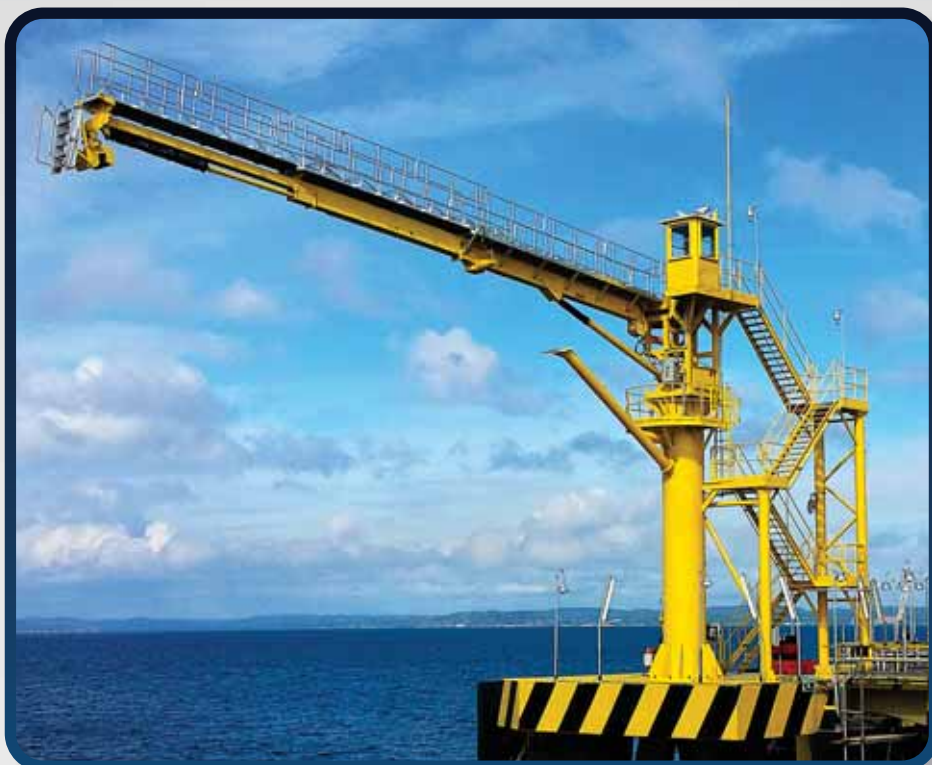
TRANSPETRO - TERMINAL DE REGASEIFICAÇÃO TRBA; SALVADOR - BA - ALTURA DA COLUNA: 11,5 m - ALCANCE DA PASSARELA: 20 m
